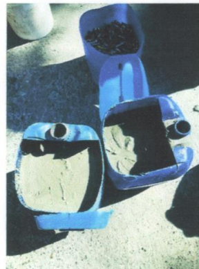
Relleno de las pilas con cemento
